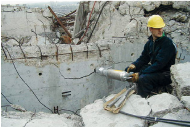
Abb. 7 Spalten durch Pressen – Keilprinzip
