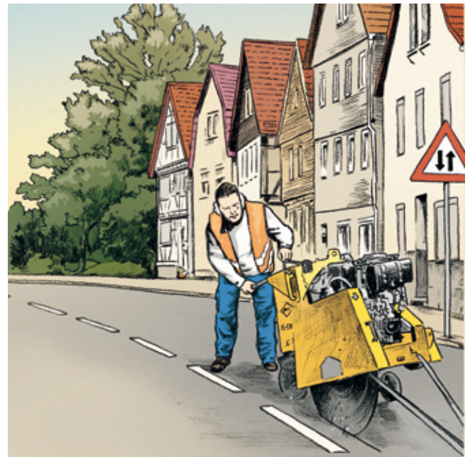
Abb. 3 Fugenschneiden
