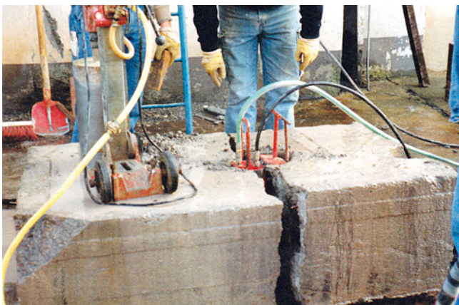
Abb. 8 Spalten mit Presszylindern
